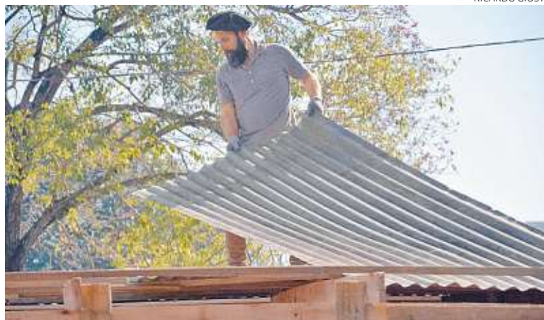
Estruturas devem estar finalizadas até o próximo domingo, dia 1º/9
